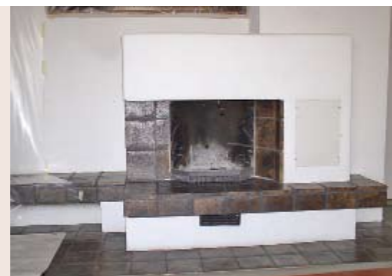
Energieschleuder: Der offene Kamin in dem 70er-Jahre-Haus sollte durch einen Kachelofen ersetzt werden.
