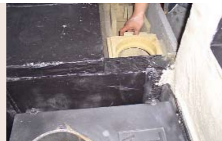
Blick ins Innere des neuen Ofens: Die Züge werden gemauert. Der 7-kW-Heizeinsatz stammt von Leda.
